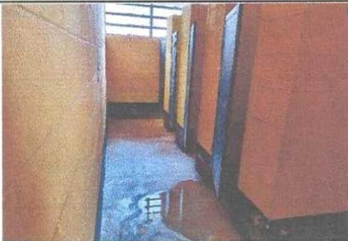
FOTO 3. En la batería de baños de niñas(4 sanitarios) se observa la fuga de agua.
