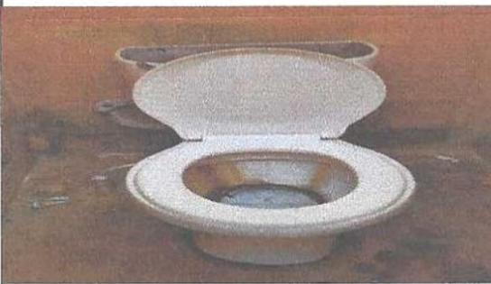
Foto 5: Se observa el mal estado dentro y fuera de las tazas sanitarias.
